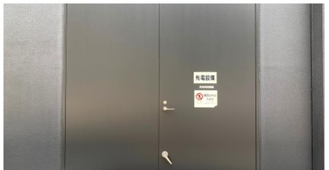
洪水対策として、重要設備への浸水を防ぐため止水扉を設置しています。
